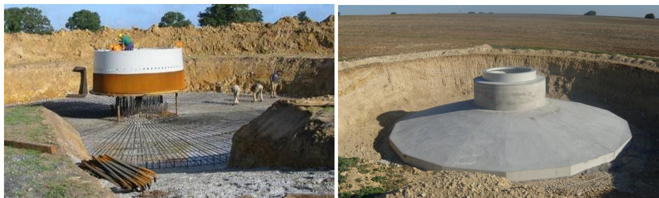
Photo 1 : Le ferrailage et le coulage d'une fondation d'éolienne
