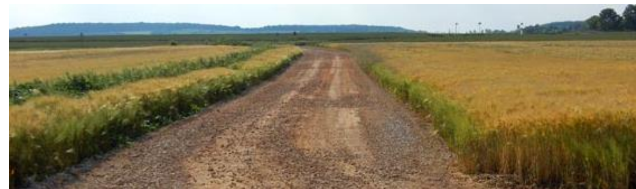
Photo 2 : un exemple de voie d'accès à un parc éolien en milieu agricole
