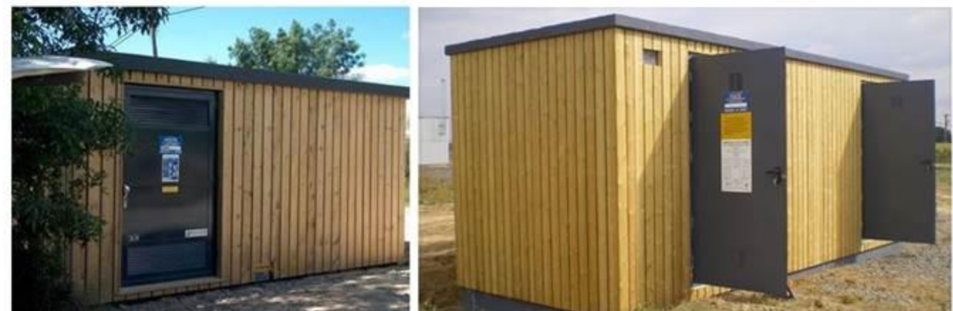
Photo 3 : exemple de poste de livraison électrique
